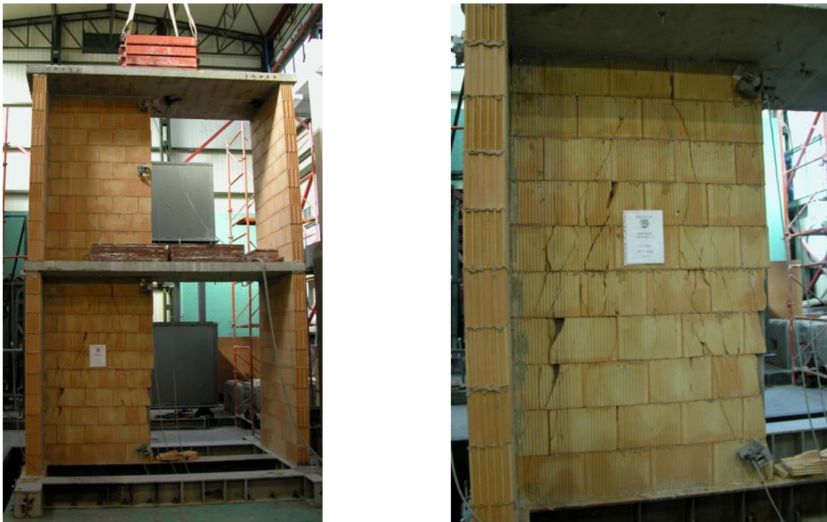
Bild 5: Prüfkörper mit Schubwand aus Füllziegeln mit Randbewehrung nach einem Erdbeben mit einer nominellen Bodenbeschleunigung von 2,6 \text{ m/s}^2 Gesamter Prüfkörper (linke Darstellung) und Schubwand im EG (rechte Darstellung)
