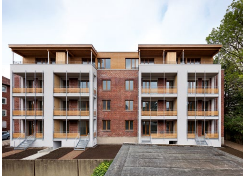
▲ Die Räume zur ruhigen Hofseite verbinden sich durch Glastüren mit der großzügigen Loggia, die einen wettergeschützten Außenbereich als erweiterten Wohnraum bietet.
