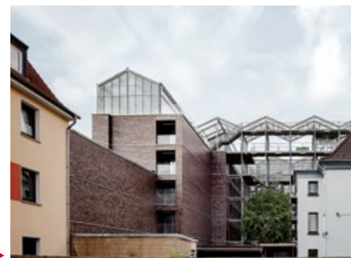
Die Abluft aus dem Bürogebäude wird in das Gewächshaus geleitet und fördert dort das Pflanzenwachstum. ▶
