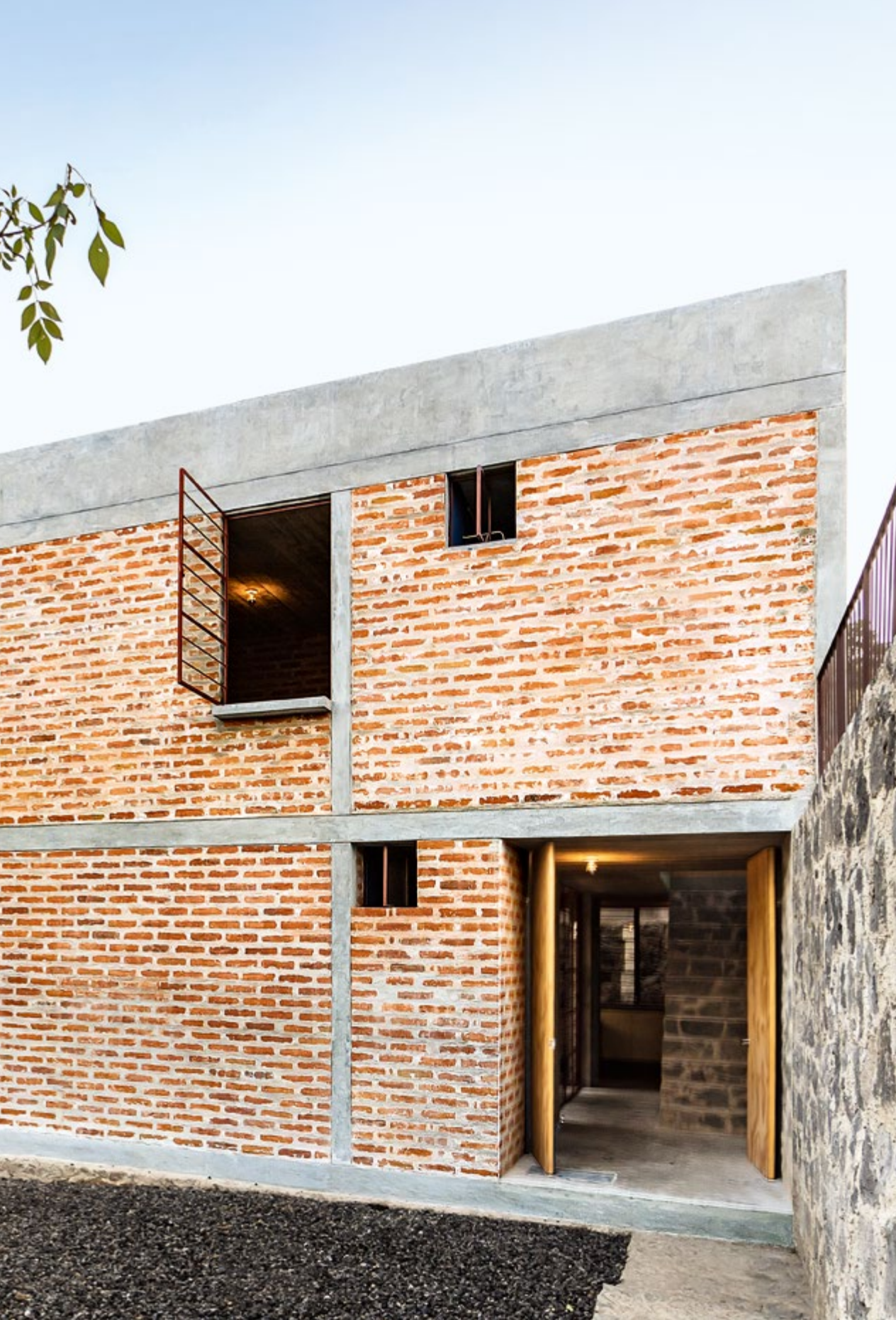
▲ Ein Betonskelett gefüllt mit Ziegeln bildet die Hülle für einen Ruhepol in Mexiko-Stadt.
