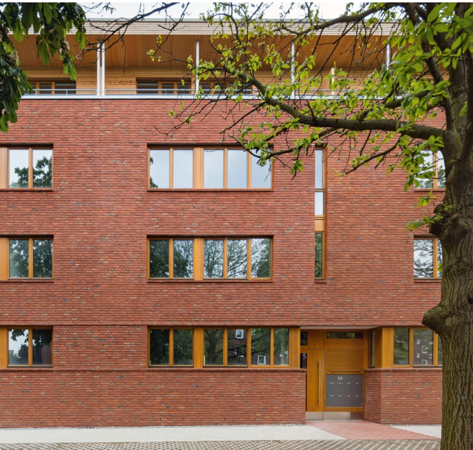
▲ Der Dreiklang aus Altbau, Anbau und Staffelgeschoss in Holzrahmenbauweise ergibt ein attraktives, differenziertes Gesamtbild.
