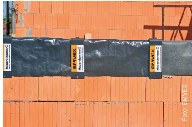
Bild 9: Schutz des Mauerwerks im Bauzustand
