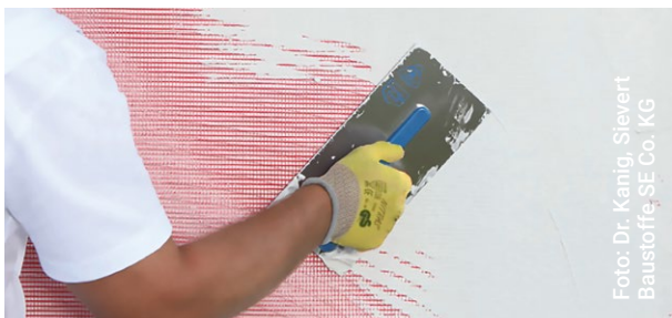
Bild 5: Vollflächiges Einbetten des Armierungsgewebes in einen Armierungsmörtel
