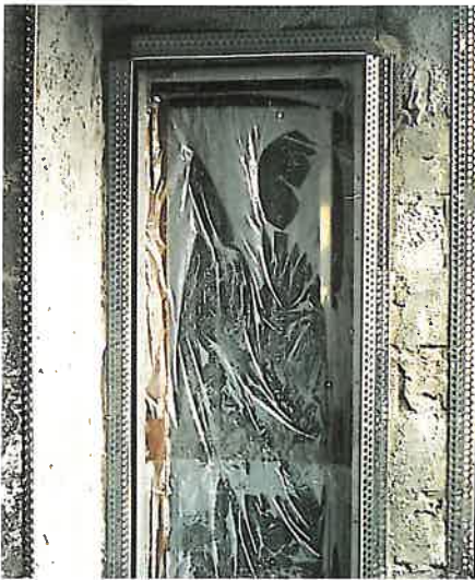
Zuerst die Eckschienen setzen.
