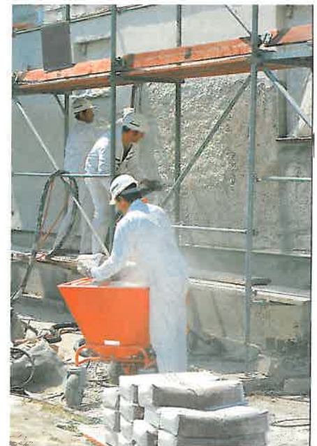
Wärmedämmputz wird als Werk-trockenmörtel angeliefert und mit Hilfe bewährter Misch- und Förder-technik verarbeitet.
