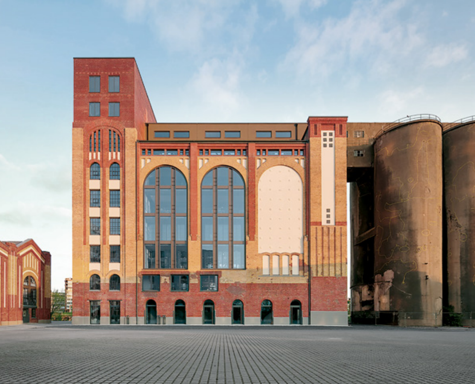
▲ Gebäudehohe Rundbogenfenster sowie der Wechsel von Backstein- und Putzflächen kennzeichnen das ehemalige Holzsilos.
