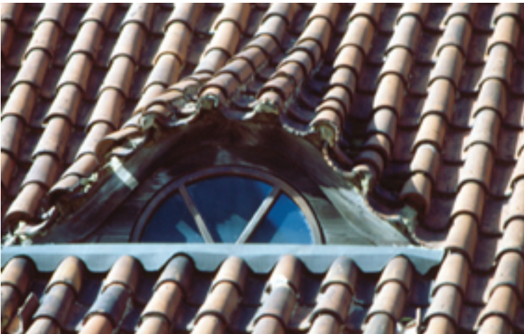
Sehr seltene Fledermausgaubenform im Mönch-Nonne-Dach
