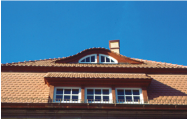
Fledermausgaube und Schleppdachgaube
